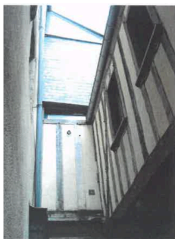
Coursive entre le 14 et le 16 rue Poterie
